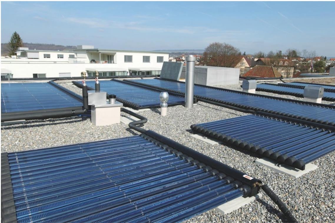
Des collecteurs par tube sous vide, ici photo du AURON DF, sont fréquemment installés sur des toits plats, puisque les tubes peuvent facilement être alignés selon l'orientation du soleil
