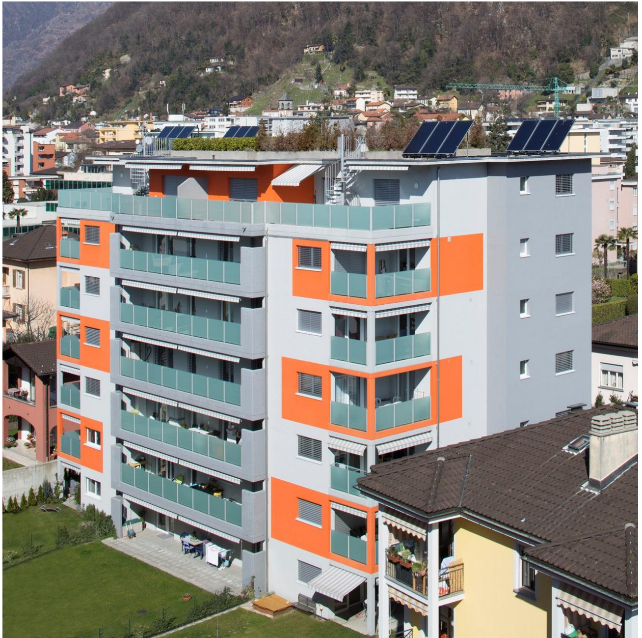
Avec sa pompe à chaleur couplée au solaire, la Residenza Opale à Locarno s'est dotée d'une solution de chauffage économique et respectueuse de l'environnement (photos ELCO/Gaccioli)
