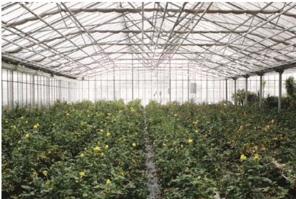
Bild 5: Blick in ein Gewächshaus: Die Wärme wird über Oberleitungen sowie eine Vegetationsheizung im Wurzelbereich abgegeben.
