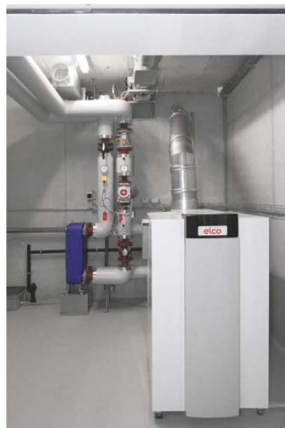
Bild 4: Gas-Brennwertkessel R602 für das Panorama-Center: Vormontierte Systembausätze vereinfachen die Planung und verkürzen die Montagezeiten.
