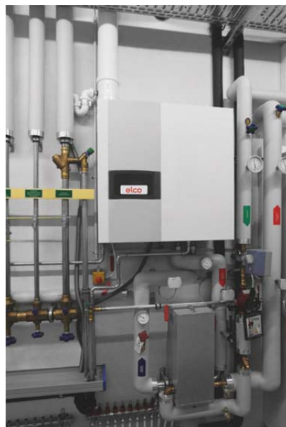
Figura 6: Grazie all'ampia modulazione la caldaia a gas a condensazione THISION S raggiunge elevati rendimenti annui. Nell'immagine la THISION S 45 E del centro fitness.
