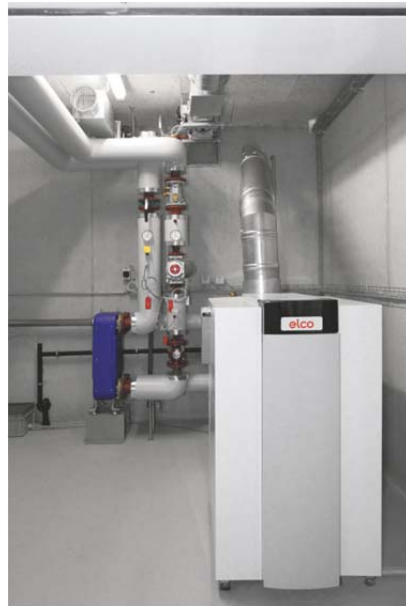
Figura 4: Caldaia a gas a condensazione R602 per il Panorama Center: i moduli di sistema premontati agevolano la progettazione e riducono i tempi di montaggio.
