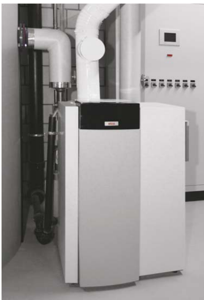
Figura 5: TRIGON L per l'Arena Thun: grazie alle dimensioni compatte la potente caldaia a gas a condensazione richiede poco spazio.
