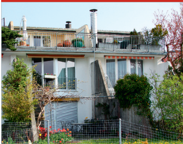
Vue partielle du lotissement Lehnisweidstrasse à Widen composé de 50 logements de tailles différentes.
