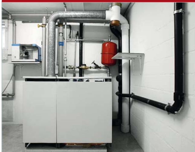
La vecchia caldaia atmosferica a gas prima dello smantellamento.
