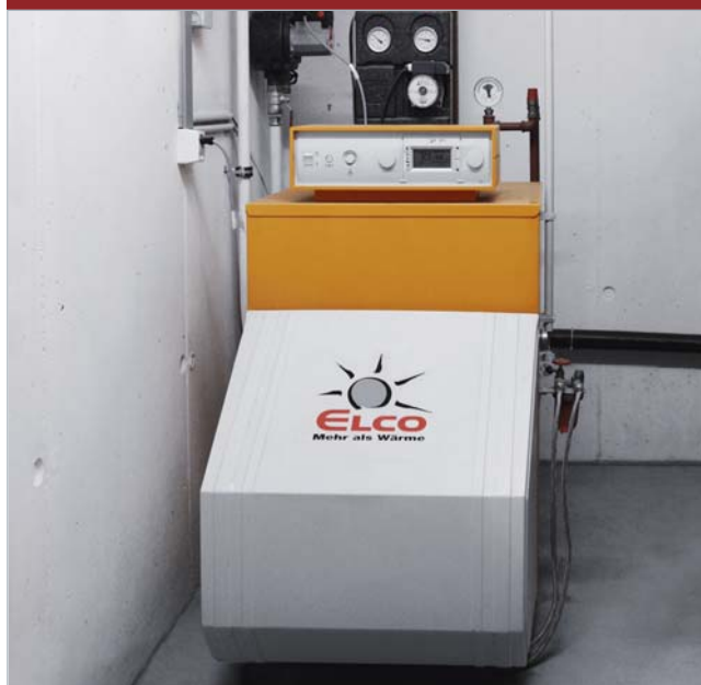
La vecchia caldaia a gasolio prima dello smantellamento.
