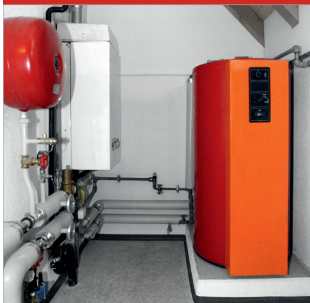
Il vecchio impianto prima dello smantellamento.
