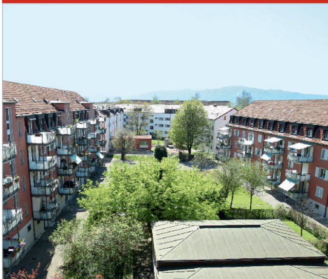
Blick auf die Wohnanlage Scheuchzer-/Stüssistrasse in Zürich, in der die Heizung modernisiert wurde.
