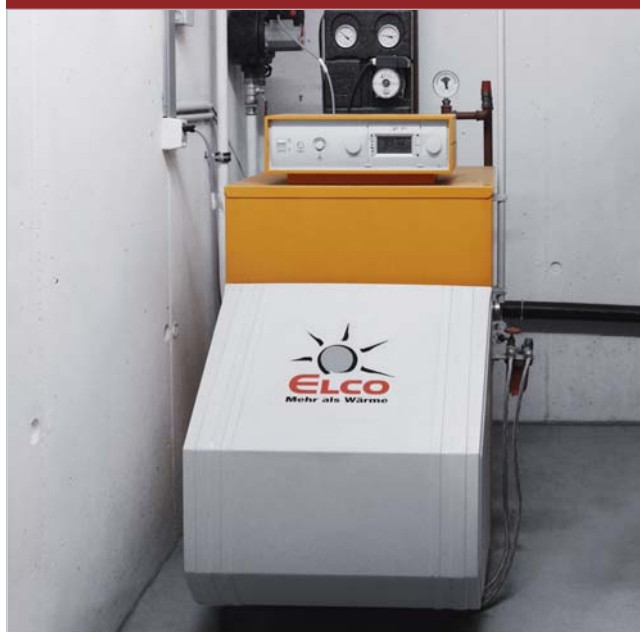
Die alte Ölheizung vor der Demontage.
