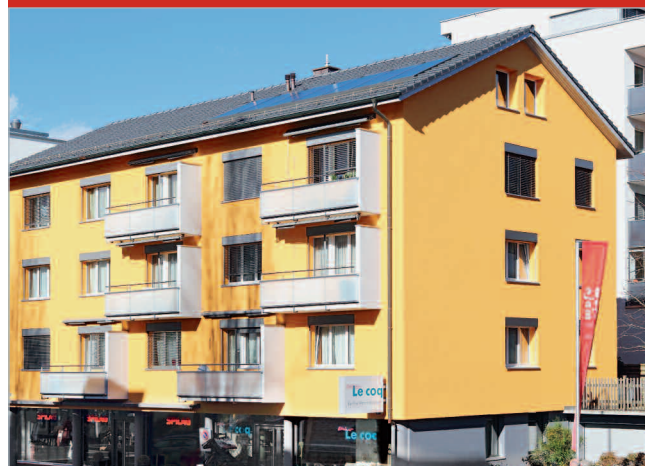
Das Mehrfamilienhaus von Walter Bättig im Zentrum von Wettingen mit der Indach-Solaranlage SOLATRON S 2.5 V.
