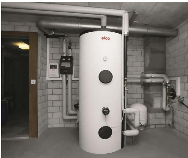
L'accumulatore combinato VISTRON THS 600/300 è installato nell'ex locale cisterna e offre un elevato comfort dell'acqua calda.
