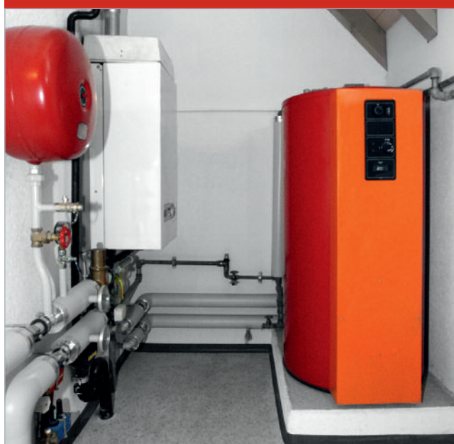
Die alte Gasheizung vor der Demontage.
