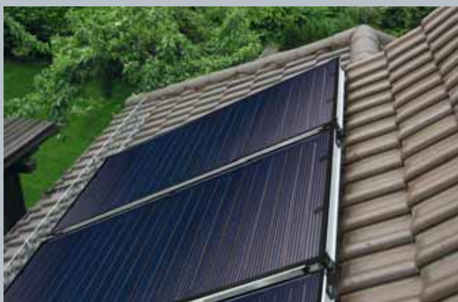
Montaggio applicato sul tetto
