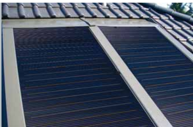
Montaggio integrato nel tetto
