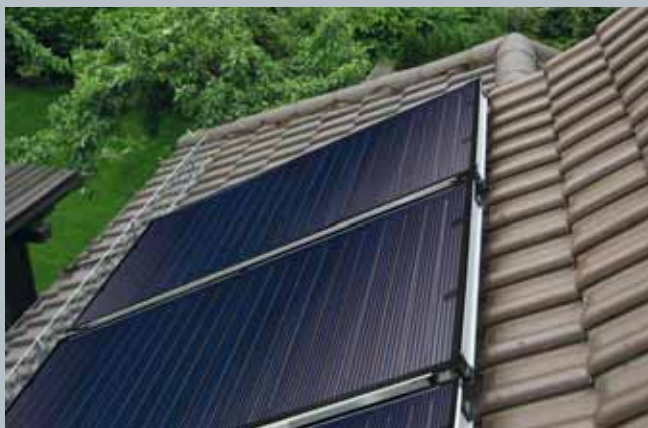
Montage sur toiture
